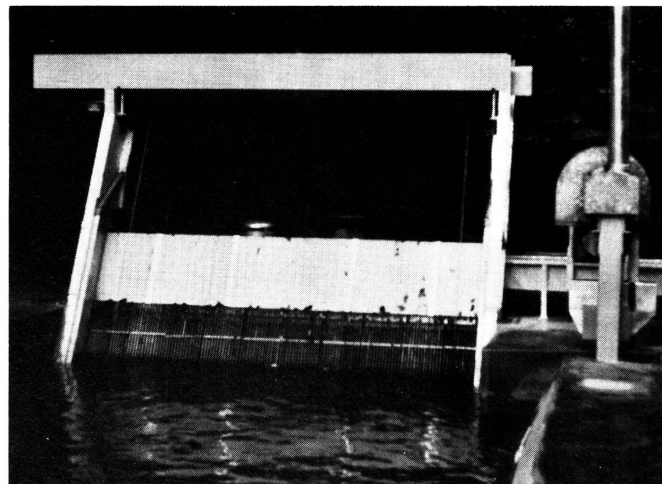
Spinnerei an der Lorze, Baar: Rechenreinigungsmaschine und Schütze
