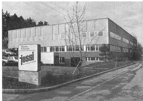
Zwischen SBB-Anschluss und alter Landstrasse im Grünen die zweckmässige und lichte Fabrikliegenschaft
