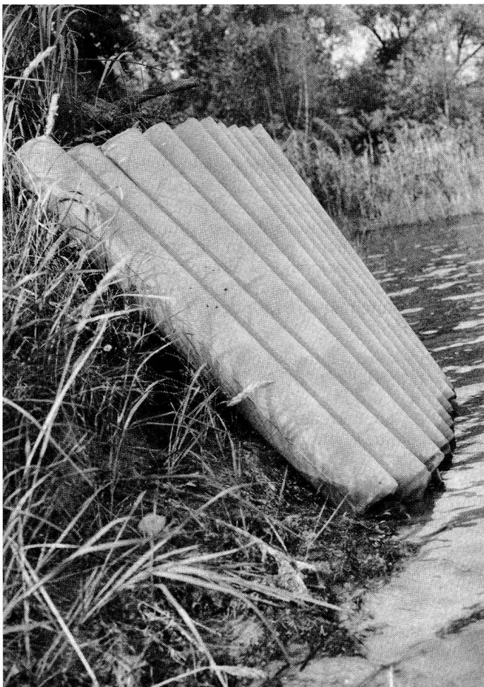
Raschelgewirkte Füllhandschuhe für den Uferschutz (mit Beton vor Ort gefüllt) (Karl Mayer)
