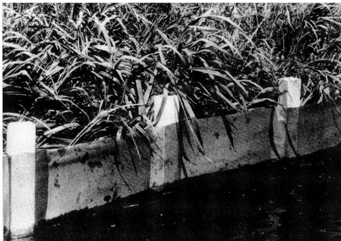
Raschel-Doppelgewirk für den Uferschutz (Karl Mayer)
