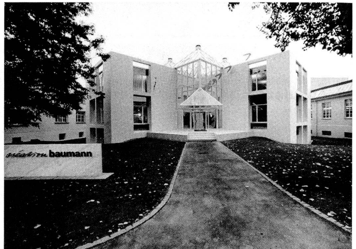
Das neue Bürohaus von Création Baumann
