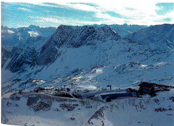
Deutschlands höchstgelegenes Skigebiet kann nun mit der Zahnradbahn direkt angefahren werden. Der Bahnhof liegt direkt an den verschiedenen Liften (Bauzustand April 1987).
