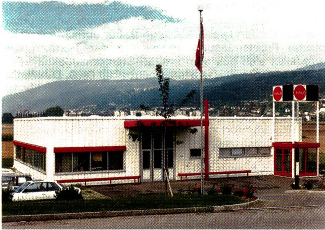
Blick auf das Werk der Haug Biel AG in Biel. Haug zählt weltweit zu den Pionieren unter den Herstellern von Static-Eliminatoren.
