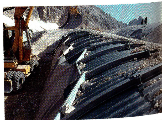
Die Ausgleichsschicht zwischen dem Geotextil und dem Bahnhofsprofil wird aufgebracht. Deutlich zu sehen ist das Profil mit den Trägern. Foto Höchst AG.
