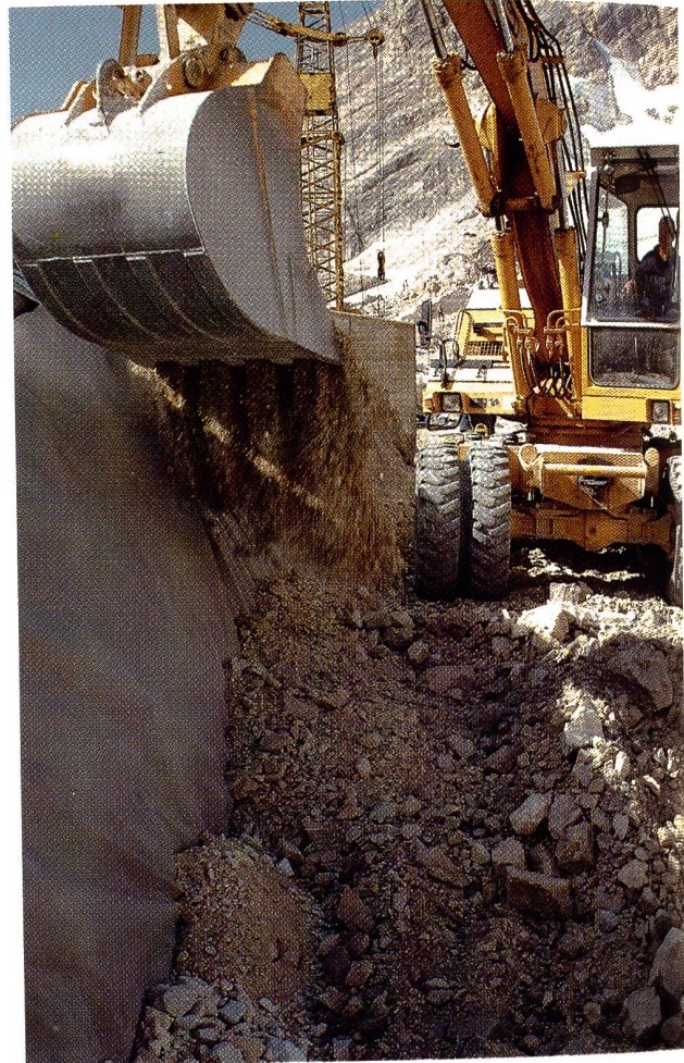
Auch beim direkten Beschütten mit scharfkantigen Steinen oder Blöcken wird die mit Trevira® Hochfest versehene Dichtungsbahn von Trevira® Spunbond vor Beschädigungen geschützt. Foto Höchst AG.
