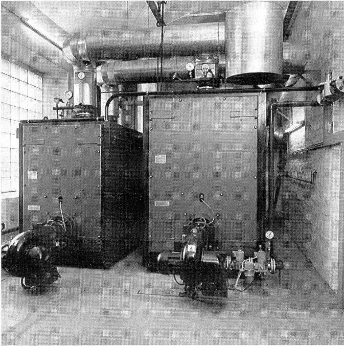
Bild 3: Neue dezentrale Kesseleinheiten
