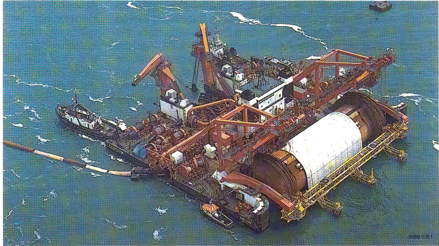
Bild 11 Die «Cardium», mit der die Filtermatratzen transportiert und zentimetergenau auf dem Meeresboden ausgelegt wurden.
