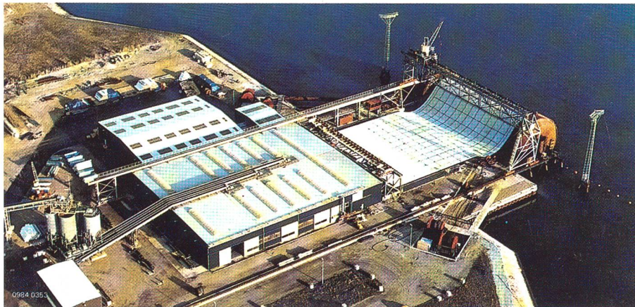
Bild 9 Produktionsstätte auf der Arbeitsinsel Neeltje Jans, wo die Filtermatratzen in einem kontinuierlich ablaufenden, vollautomatisierten Arbeitsprozess hergestellt wurden.
