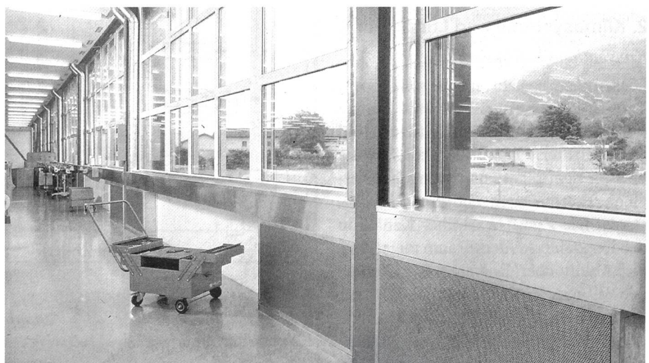
Liptex-Klimaanlage bei Schoeller Switzerland
