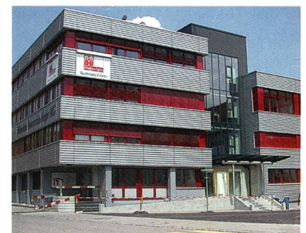
Neues Textil-Technikum von Heberlein Fasertechnologie AG
