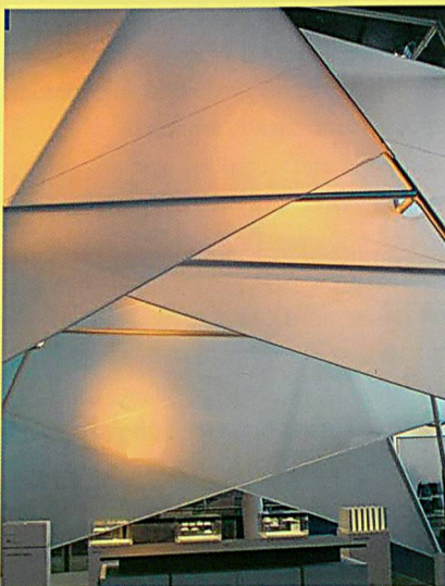
Membranbau – HF – Schweissen
