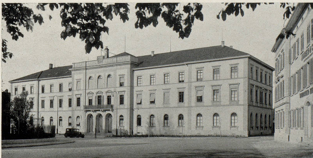
Das Regierungsgebäude nach der Renovation.
