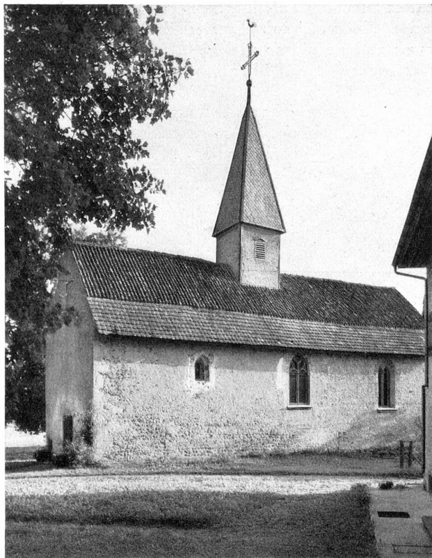
St. Leonhardskapelle in Landschlacht von Süden Links der älteste Teil mit kleinem, romanischem Fenster Eine zweite romanische Luzida in der Mitte ist durch ein größeres spätgotisches Fenster ersetzt worden
