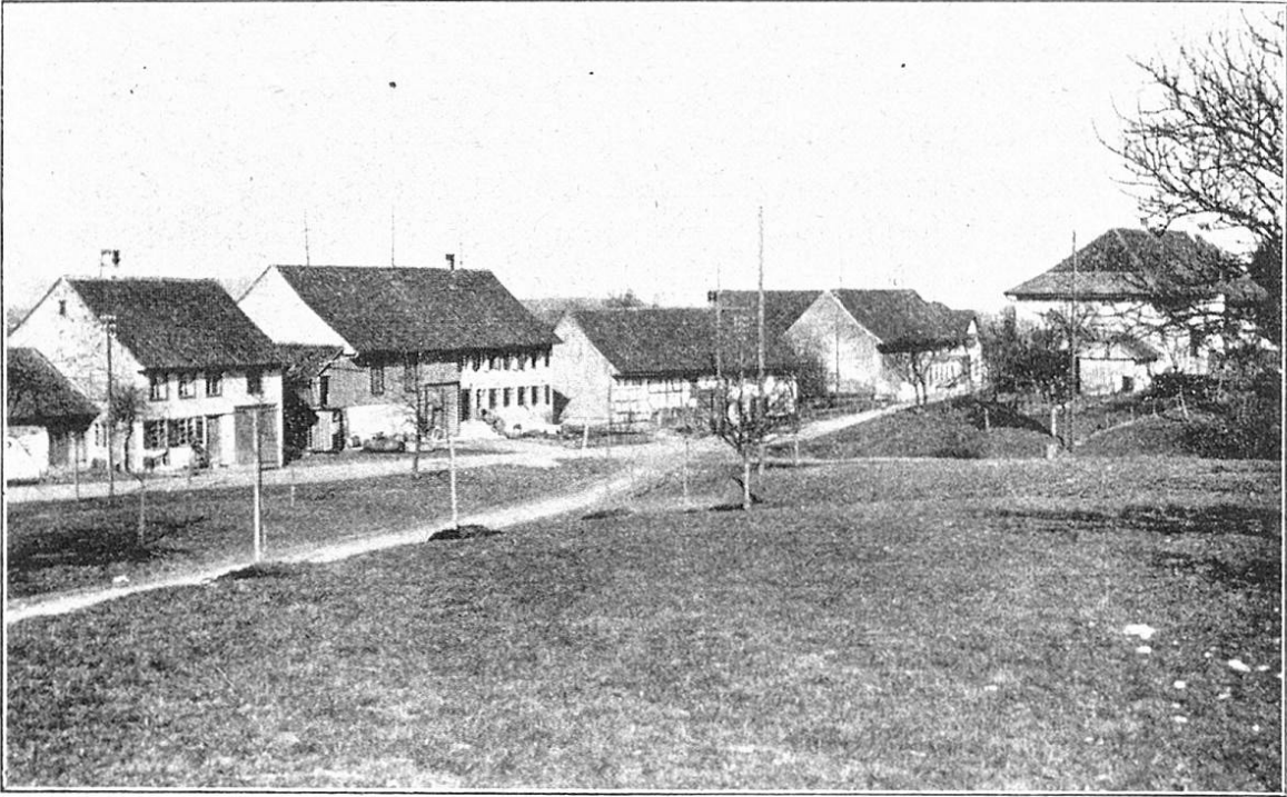
Abb. 6. Miesenried (Thurtal): Verstärkte, „blinde“ Mauerwände. (Schutz gegen den Westwind.) Reihenstellung der Häuser in Windrichtung.
