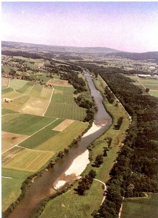
Abbildung 6: Aufweitungen im Abschnitt Rorerbrücke–Uesslingerbrücke. Blickrichtung flussaufwärts, ab Uesslingerbrücke
