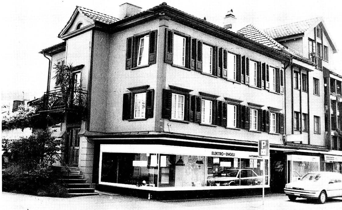
Im damaligen katholischen Schulhaus (heute Elektro Engeli) wurde im Mai 1864 die als Aktiengesellschaft geführte Realschule eröffnet.
