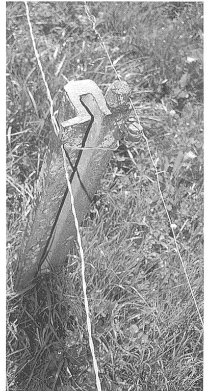
Ein Relikt aus der Zeit der ersten Südostbahn, eine englische Brückenschiene, wurde kürzlich im Werdenbergischen in der Form eines Hagpfostens gefunden.
