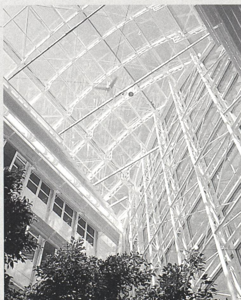
Betriebsgebäude EWZ, Zürich
