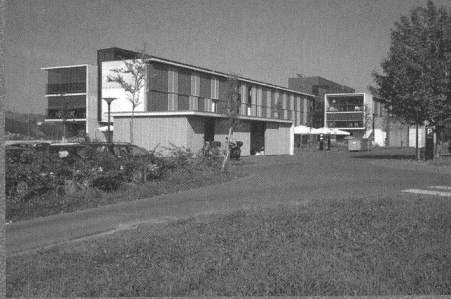
Architektur Bysäth + Linke, Luzern Foto: E. Kuenzi, Langnau a. A.
