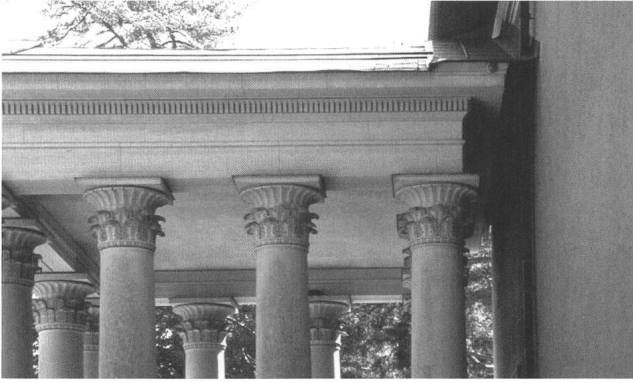
Sigurd Lewerentz, Uppståndelsekapellet Skogskyrkogården , 1921, dettaglio delle colonne del pronao di ingresso
