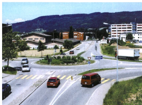
Kreisverkehrsplätze in Volketswil, Uster, Bülach, Embrach und Neftenbach, Zustand um 2005, Fotos der Baudirektion Kanton Zürich.
