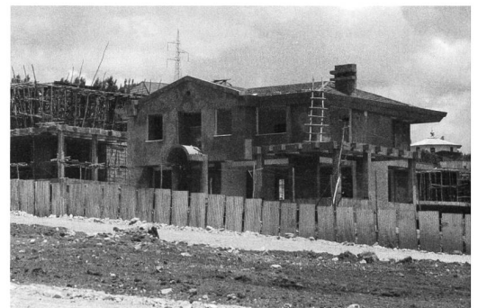
Rohbau, CMC Areal in Addis Abeba, 2009. Die Formsprache verweist auf US-amerikanische Vorbilder. Foto: Jörg Himmelreich.
