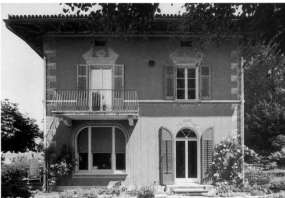
Abb. 13 Zug, Artherstrasse 29, «Casa Rossa». Seitenfassade von Süden, 1989.
