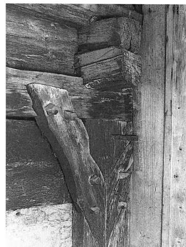
Abb. 3 Baar, Kirchgassee 13. Zweites Obergeschoss, Giebelseite West. Kopfstreben eines zweigeschossigen Mittelständers (datiert 1470).
