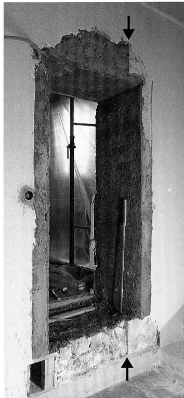
Abb. 8 ◁ Zug, Kloster Maria Opferung: Blick von Südwesten auf die wohl ursprüngliche Südwest- ecke der Kirche (Pfeile) mit bereits wieder verschaltem Türdurchbruch im Erdgeschoss.
