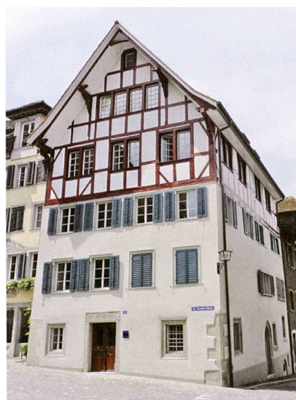
Abb. 12 Zug, Haus St.-Oswalds-Gasse 10. Blick von Osten.
