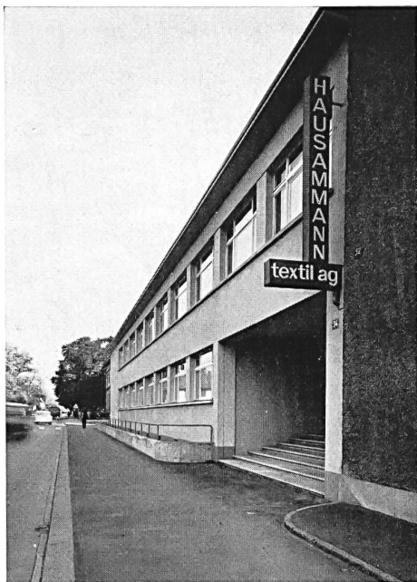
Entrada principal que da a la calle St. Gallerstrasse
