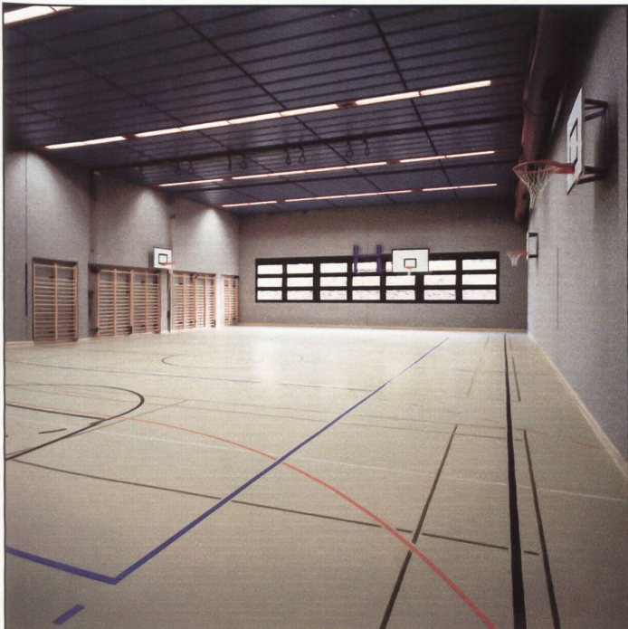
Lehnringsturnhallen Winterthur: 2500 m 2 Kugelgarn-Belag «Pamir», Kolorit «Wiesel», verlegt als Wandverkleidung. Nutzschrift 40% Schurwolle, 35% Polypropylen, 25% Schurziegenhaar. Einsatzgewicht ca. 950 g/m 2 . Gesamtdicke ca. 7,5 mm. Latexierter Federrücken.
