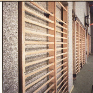
Lehnringsturnhallen Winterthur: 2500 m 2 Kugelgarn-Belag «Pamir», Kolorit «Wiesel», verlegt als Wandverkleidung. Nutzschrift 40% Schurwolle, 35% Polypropylen, 25% Schurziegenhaar. Einsatzgewicht ca. 950 g/m 2 . Gesamtdicke ca. 7,5 mm. Latexierter Federrücken.
