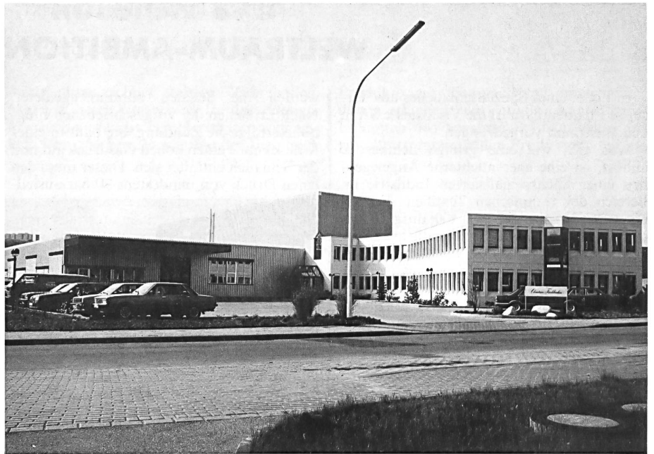
Das neue Betriebs- und Verwaltungsgebäude Christian Fischbacher GmbH, Wuppertal.
