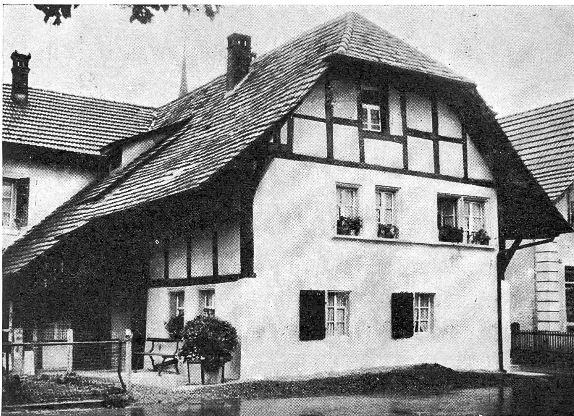
Haus Leuppi, Bahnhofstraße, Villmergen
