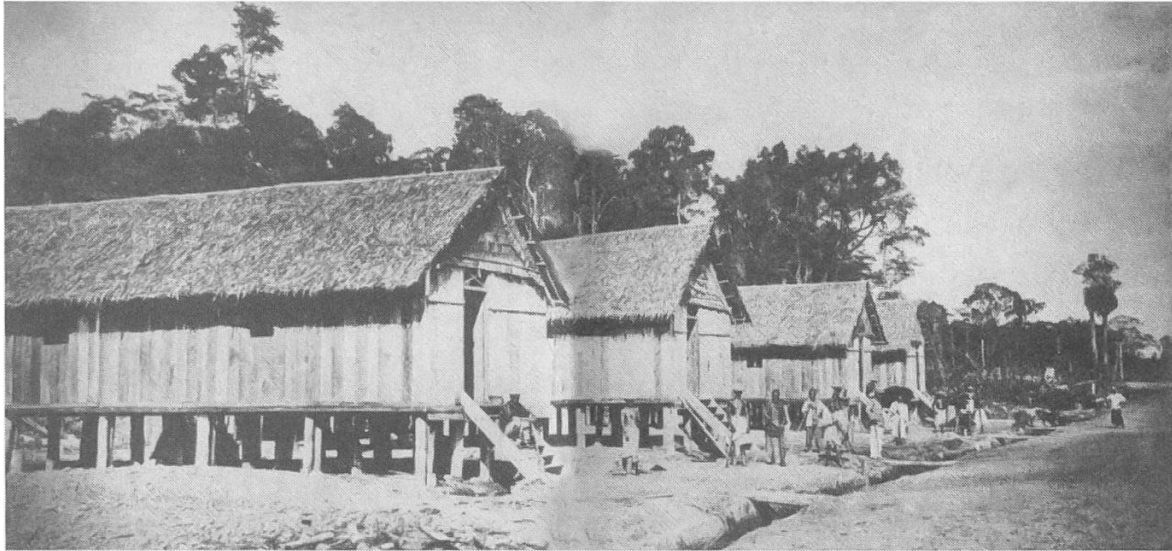
«Pahlbauten» von 4,8 m Breite, 10,8 m Länge und 2,4 m Höhe. Unterkunft für je 10 Kulis. G. E. Haarsma, Der Tabakbau in Deli, Amsterdam 1890
