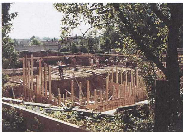
Abbildung 6: Italienische Fronarbeiter beim Bau des Asilos.
