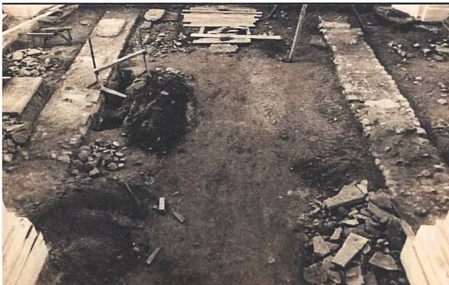
Abb. 23: Ausgrabungen 1593/54 der Grund- mauer der romani- schen Klosterkirche. Foto: Sammlung Murensia.
