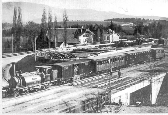
Le site des Pilettes en 1872 au début du chantier de construction du bâtiment aux voyageurs (AEF)
