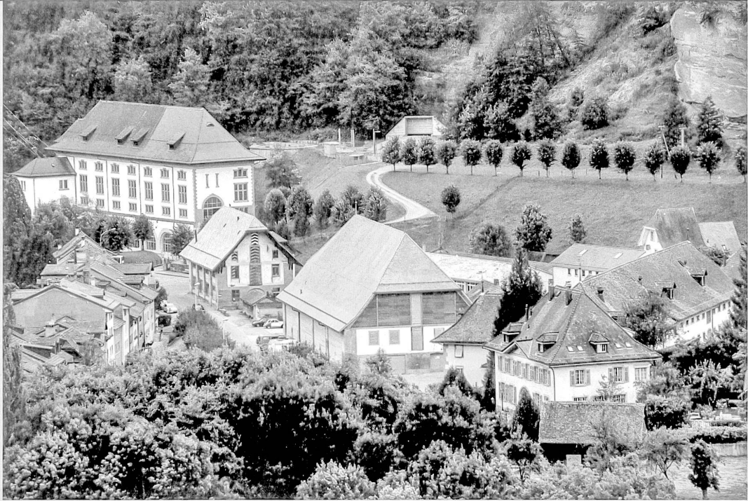
Un paysage de toits: le bâtiment d'administration de l'usine à gaz (1929), la maison de force (1751-1752), le Werkhof (1822-1824/2000-2001), le petit Werkhof ou Vannerie (1816-1817) et l'usine électrique de l'Oelberg (1910)
