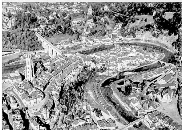
La Planche-Inférieure avec le grenier, la maison de force et les deux Werkhof, dans les années 1930. A droite, on distingue, derrière la Commanderie des chevaliers de Saint-Jean de Jérusalem, les installations de l'ancienne usine à gaz (ASBC, Photothèque, Flugbild Swissair n° 21201)
