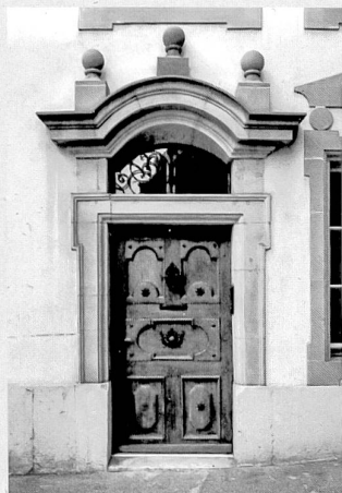
Porte de 1906 avec ferrures de remploi des années 1700, chambranle daté 1703 à l'intrados de la fenêtre en dessus de la porte
