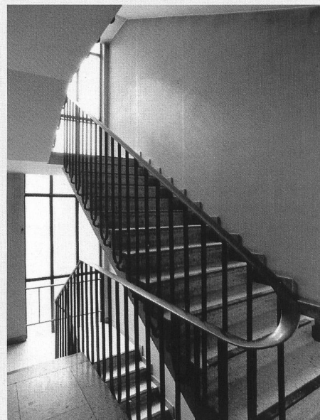
La cage d'escalier et sa rampe réalisée par le serrurier Joseph Spicher, de Fribourg
