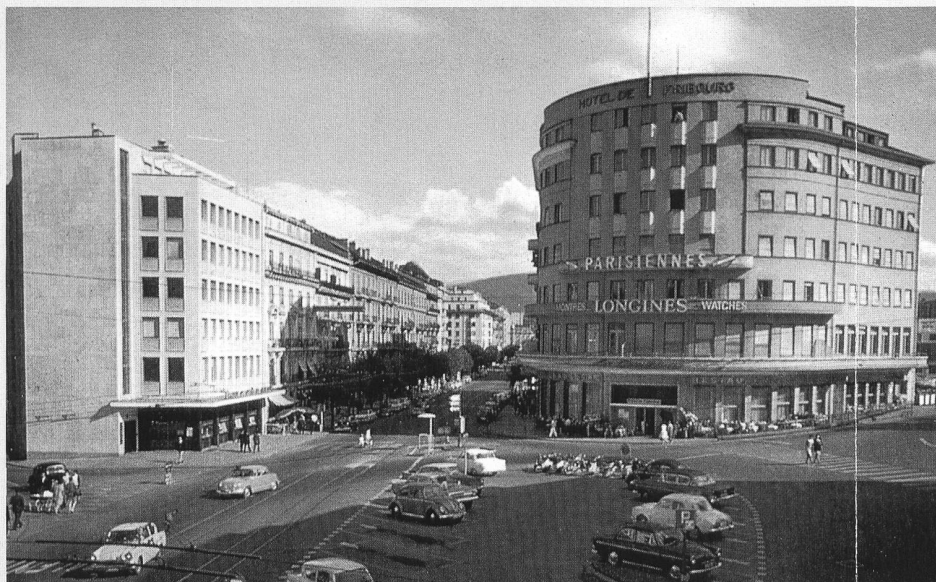
L'entrée du Boulevard de Pérolles, dans les années 1960, avec le siège de la BEF et l'ancien Hôtel de Fribourg vis-à-vis (ASBC, carte postale)
