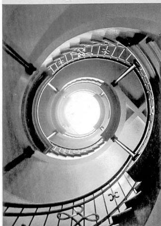
Contre-plongée sur l'escalier principal, dans le pavillon nord. L'étroitesse des distributions tranche sur la monumentalité de l'immeuble confirmant l'ampleur du programme.
