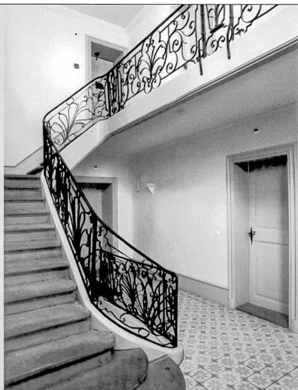
Vue de la cage d'escalier avec sa balustrade attribuable au serrurier Walther-Anton Schaller, de 1759-1761
