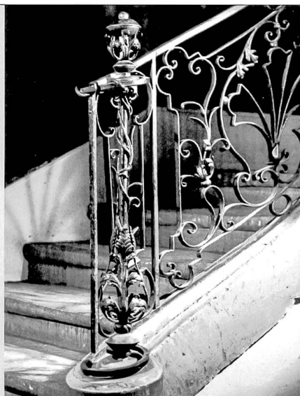
Départ de la rampe de l'escalier dans le vestibule d'entrée
