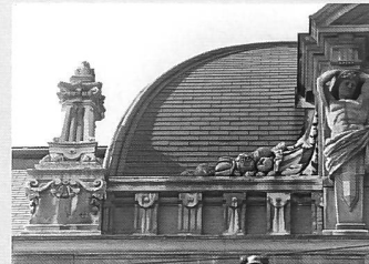
Zoom sur les détails du couronnement
