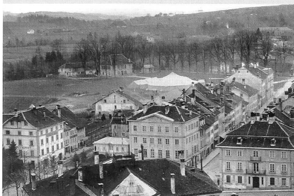
L'Hôtel des Bains, tout à gauche, peu avant sa démolition (AEF)
