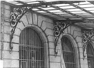
Détail de la marquise disparue en 1976
