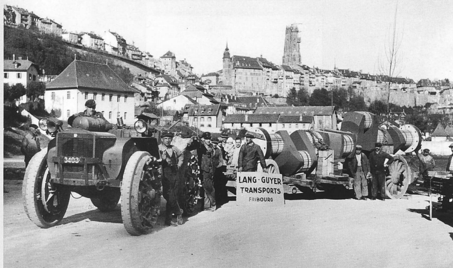
Convoi exceptionnel en Basse-Ville: le vilebrequin du moteur Sulzer en route vers la Maignrauge, le 16 octobre 1931 (Archives EEF)
