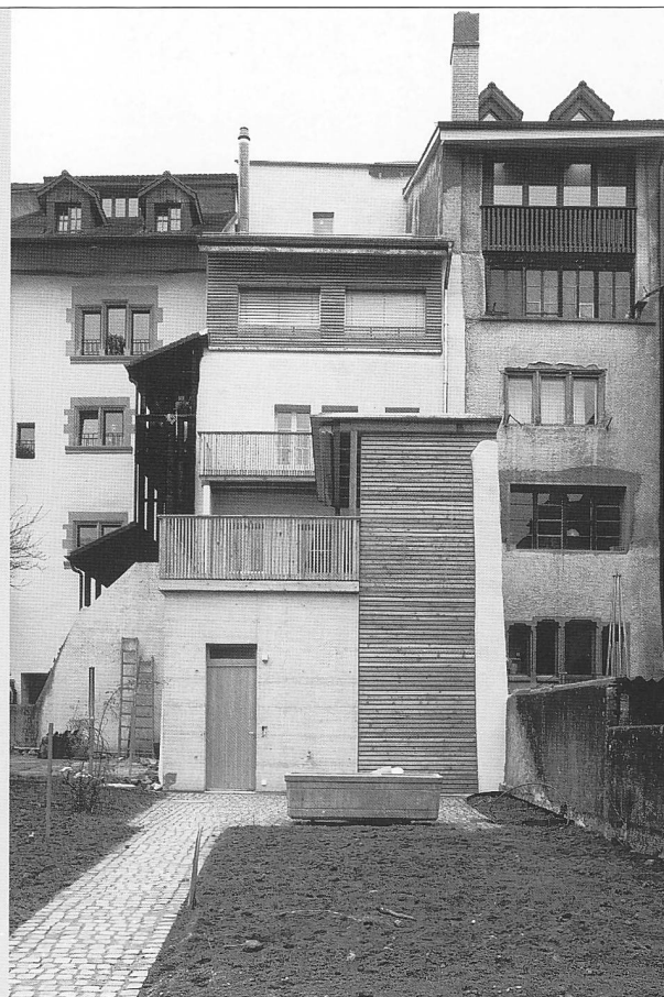
Façade arrière après restauration
