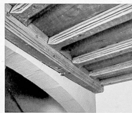
Le plafond gothique du rez-de-chaussée, vers 1417-1421
