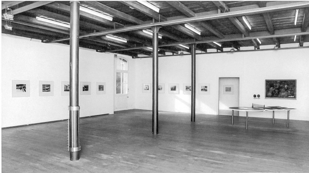
L'ancien atelier de cartonnage au premier étage, converti en salle d'exposition de FRI-ART, avec fenêtres obturées par une paroi, file de colonnes en fonte et poutres apparentes
