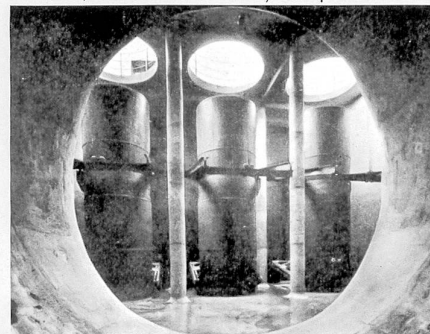
La chambre de mise en charge, haute de 9,40 m, vue du tunnel, avec ses trois vannes cylindriques en métal
