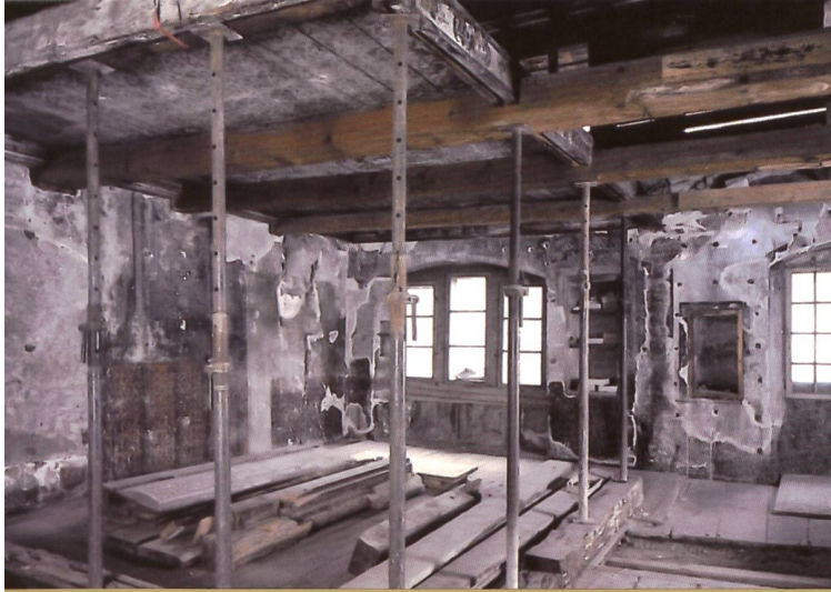
LES DEUX PIÈCES CRÉÉES EN 1518 AU DEUXIÈME ÉTAGE, CÔTÉ COUR, AVEC DÉCOR DE MAURESQUES, APRÈS 1605, ÉTAT EN 2001
