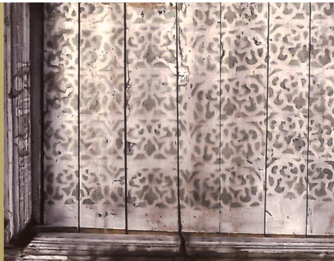
DÉTAIL DU PLAFOND DE MADRIERS JOINTIFS DE LA CHAMBRE AU TRIPLET, POSÉ EN 1518, AVEC DÉCOR DE MAURESQUES VERT SUR FOND BLANC, APRÈS 1605
