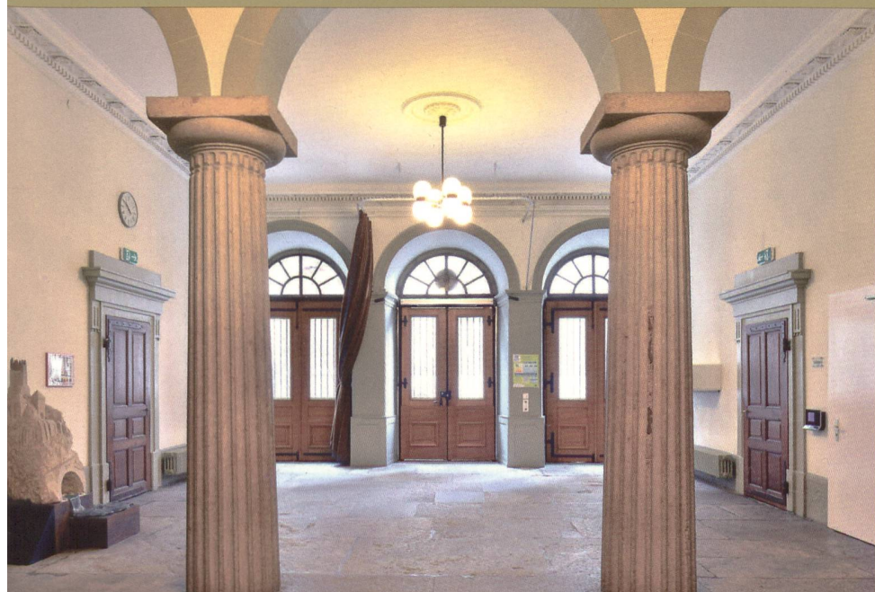
LE VESTIBULE FLANQUÉ DE DEUX BUREAUX DÈS L'ORIGINE ET DIVISÉ PAR DEUX COLONNES DORIQUES EN CALCAIRE DU JURA, VU AU BAS DU GRAND ESCALIER VERS LES TROIS PORTES D'ENTRÉE
