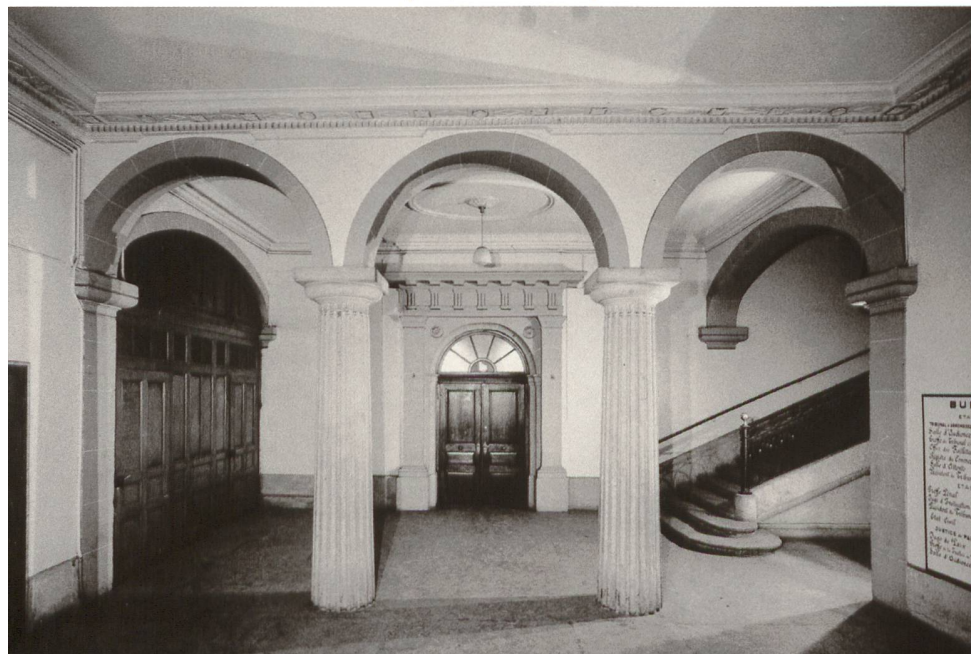
LE VESTIBULE DU REZ-DE-DE-CHAUSSÉE ET L'ENTRÉE DE LA SALLE DU CONSEIL GÉNÉRAL, VERS 1964, AVEC LA PAROI FERMANT L'ACCÈS AUX SOUS-SOLS (SBC, JACQUES THÉVOZ)
