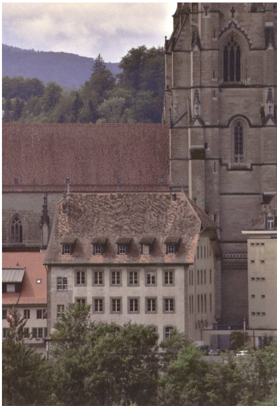
LA FAÇADE ARRIÈRE DE L'ÉCOLE DES GARÇONS AVEC LES SIX BAIES À LINTEAU DROIT ÉCLAIRANT CHAQUE SALLE DE CLASSE, LE PREMIER AXE DU CÔTÉ DE LA CURE CORRESPONDANT À L'ANCIENNE ANNEXE DES LATRINES HORS ŒUVRE DESSERVANT TOUS LES NIVEAUX
