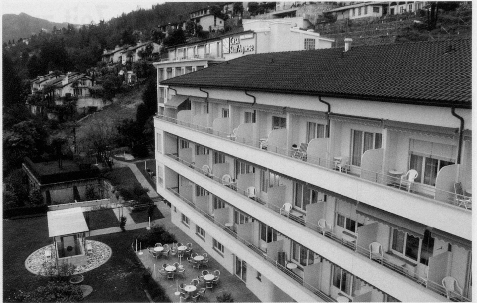
Einst war die Casa Sant'Agnese in Locarno ein Spital. Heute ist sie ein Hotel-Kurhaus mit insgesamt 80 Betten.
