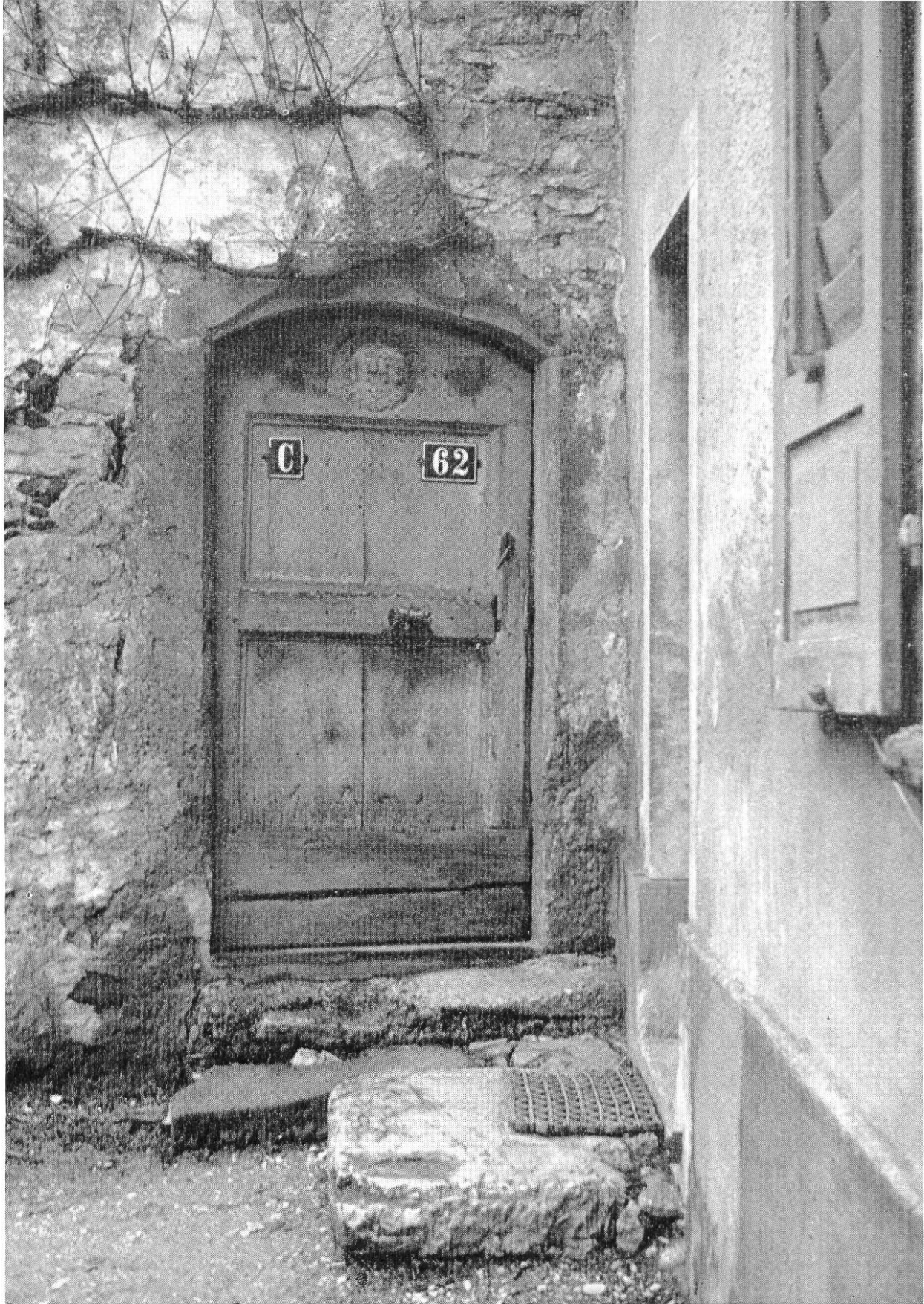
Eingang zum Treppenturm
