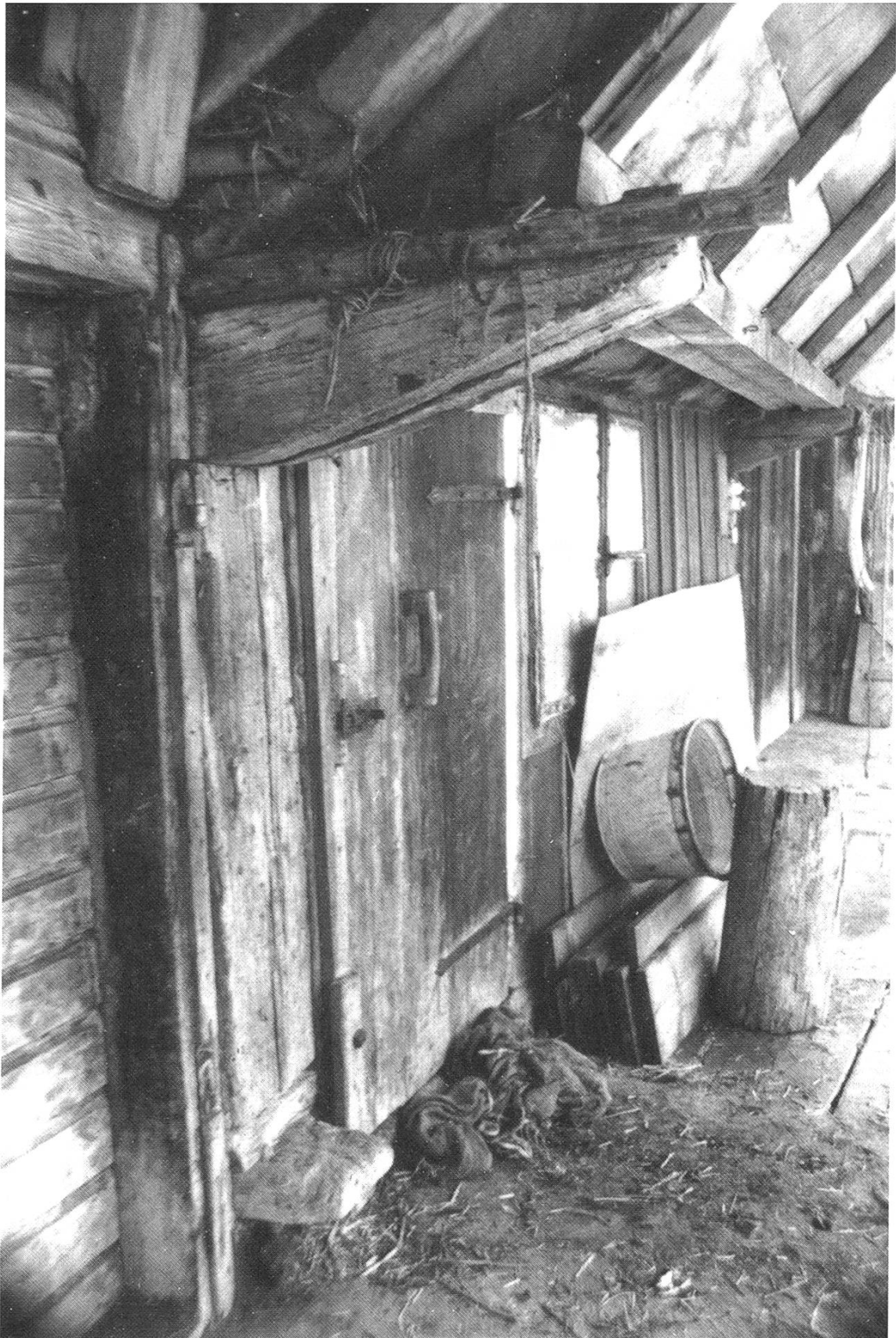
Abb. 11: Vorspringender Balkenkopf des Ankerbalkens zwischen den beiden Stalltüren.
