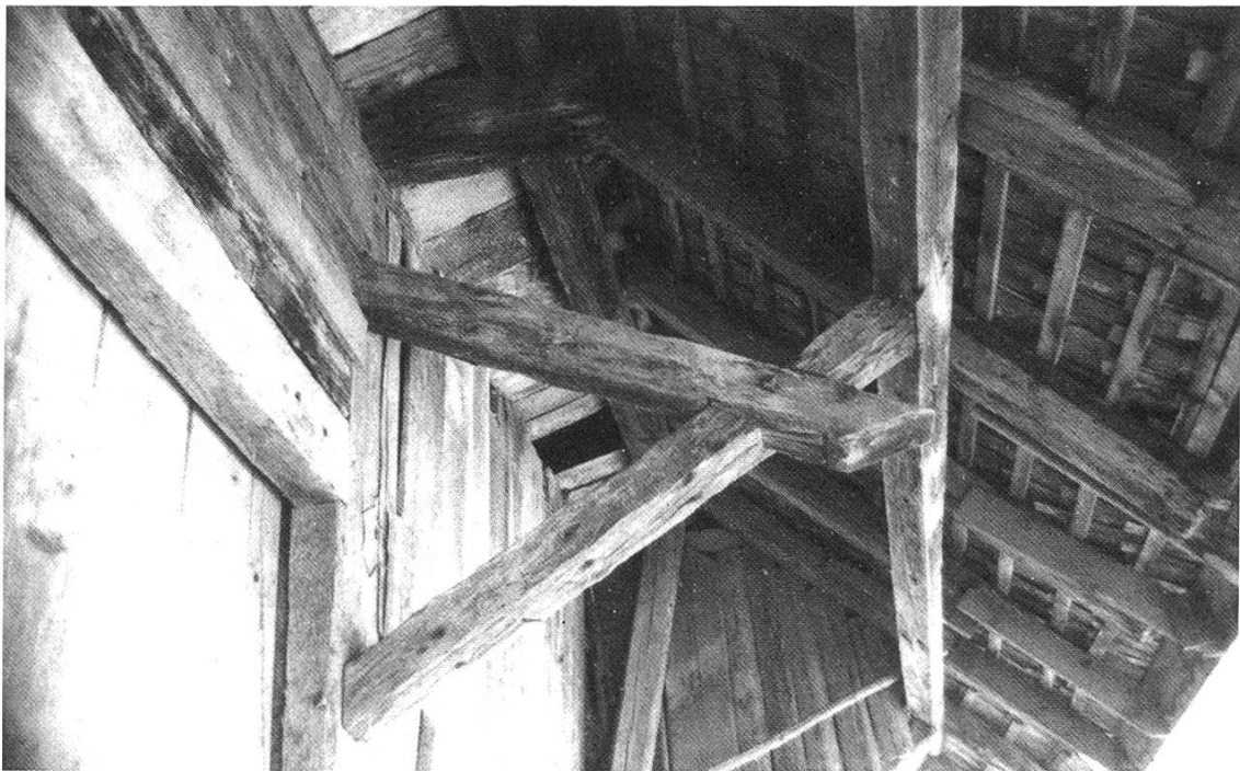
Abb. 15: Konstruktion der Flugpfette über der Scheune des Westhauses. Deutlich zu sehen ist das auf den Bug überblattete Zugband. In der Mitte oben erkennt man die vorgeschobene Wandpfette, die auf dem vorkragenden Spannbalken ruht.
