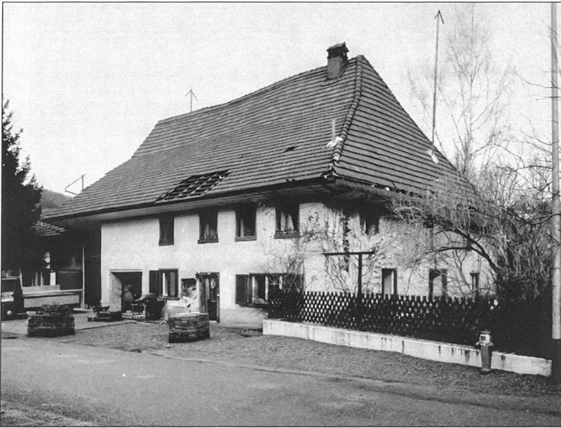
Abb. 5 Wölflinswil, Bodengasse 54. Ansicht des Firstständerbaus von 1563 kurz vor Beginn der Abbrucharbeiten.
